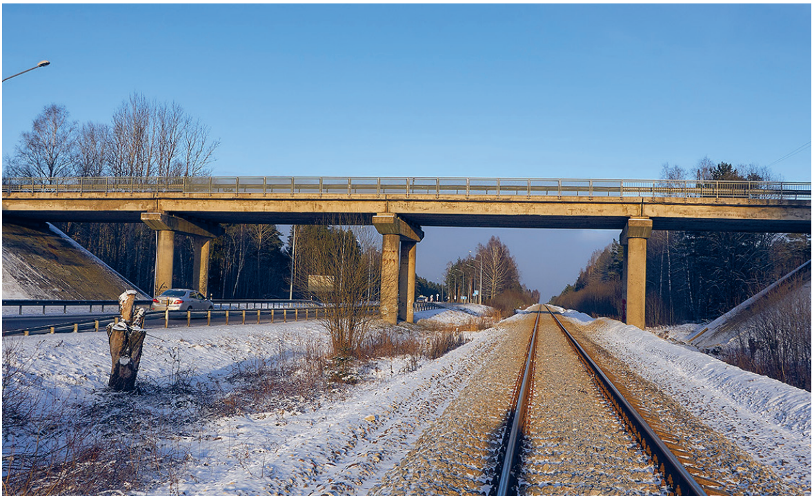
Foto 2. Tammemäe viadukt, mille idapoolne (pildil parempoolne) osa tuleb kohandada loomadele sobivaks altpääsuks; koht B1.
